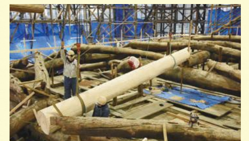
文化財建造物修理現場(本隆寺本堂)
